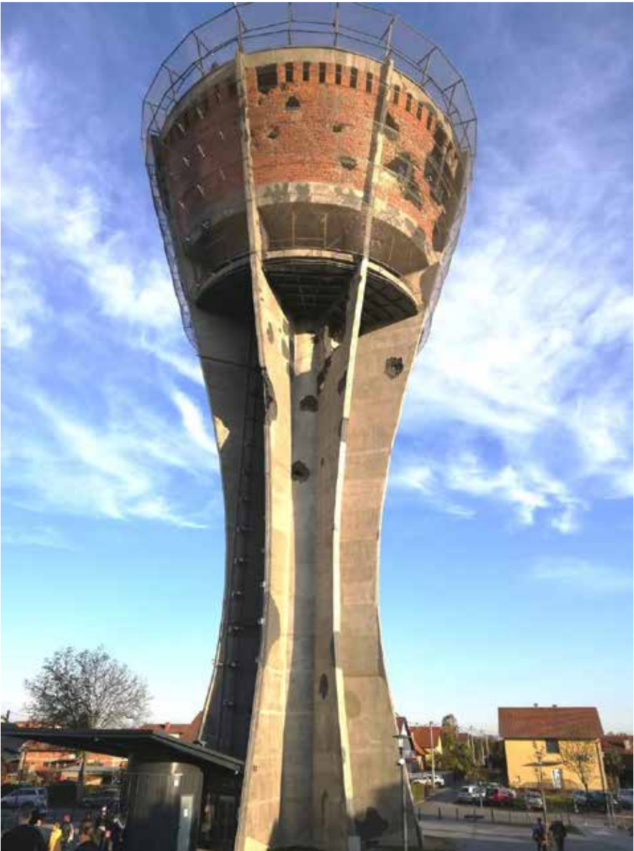
Obnovljeni Vukovarski vodotoranj - simbol Domovinskog rata
